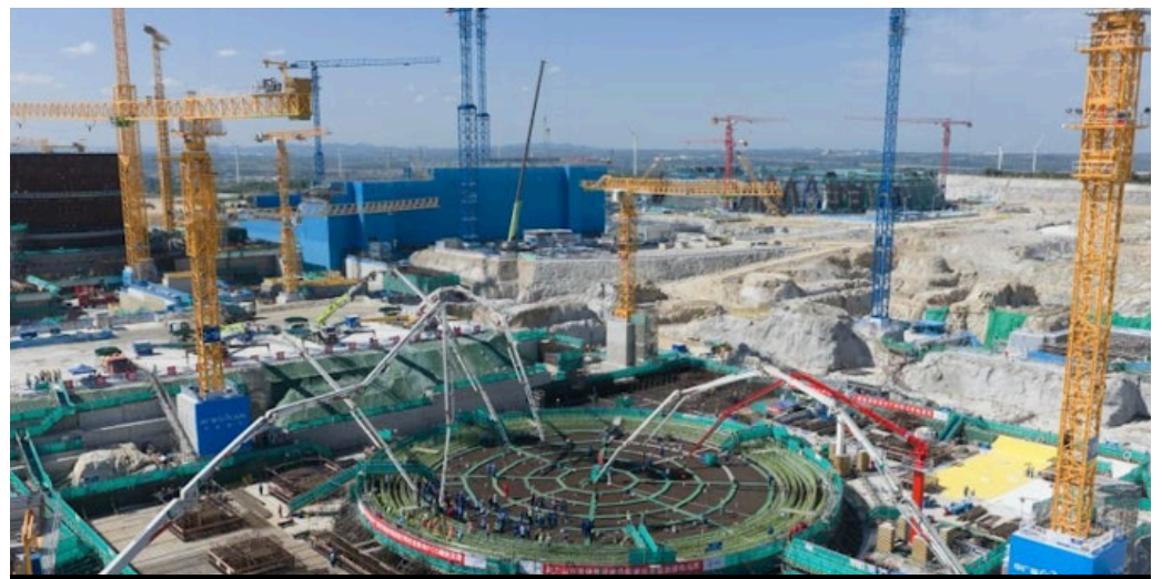
Výstavba druhého bloku jaderné elektrárny Zhaoyuan s reaktorem Hualong One v Číně [5]
