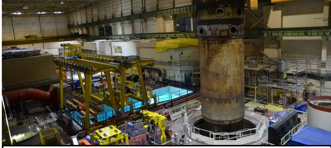
Vyjmutí reaktorové nádoby z šachty. JE Jaslovské Bohunice VI [3]
