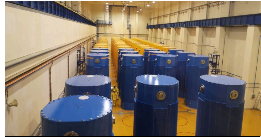
Kontejnery s použitým jaderným palivem v jaderné elektrárně Temelín [1]
