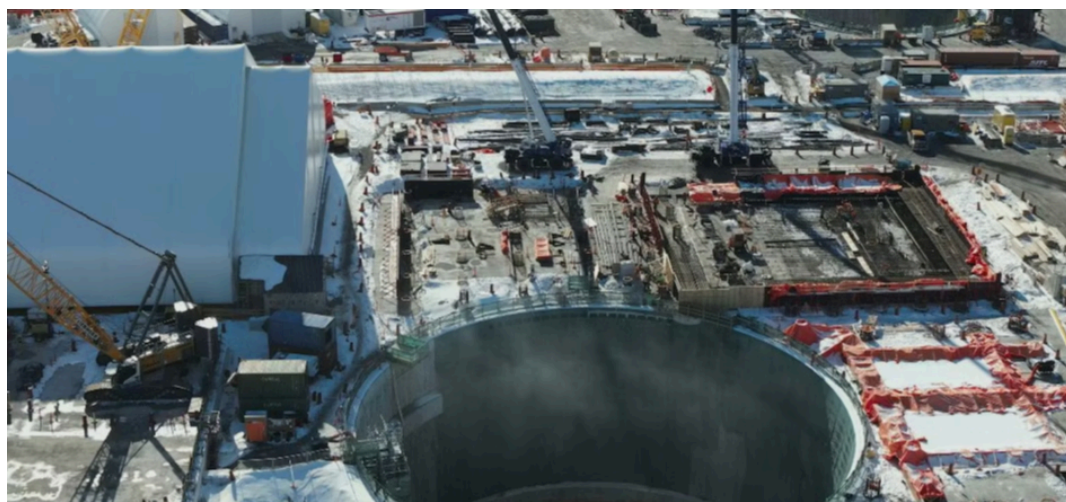
Staveniště projektu BWRX-300 v Darlingtonu, kde pokračuje výstavba prvního komerčního SMR na Západě [3]
